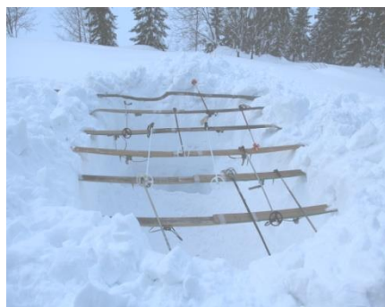
Рис. 2 Перекрытие снежной пещеры
