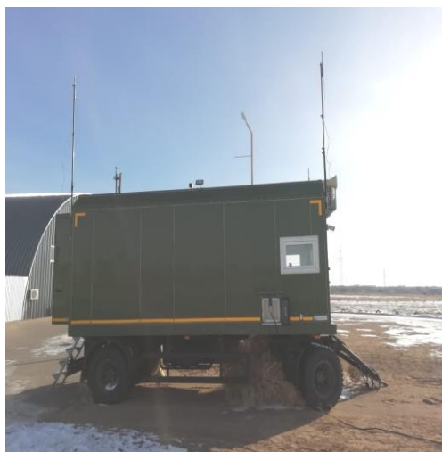
Рис. 1. Пункт управления, эксплуатации, технического обслуживания и хранения комплекса
